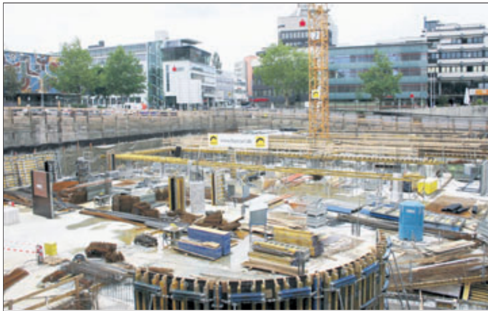
Derzeit größte Baustelle in der Stadt: der Alte Postplatz, auf dem in etwa einem Jahr ein neues Dienstleistungs- und Einzelhandelszentrum seine Pforten öffnen soll.
