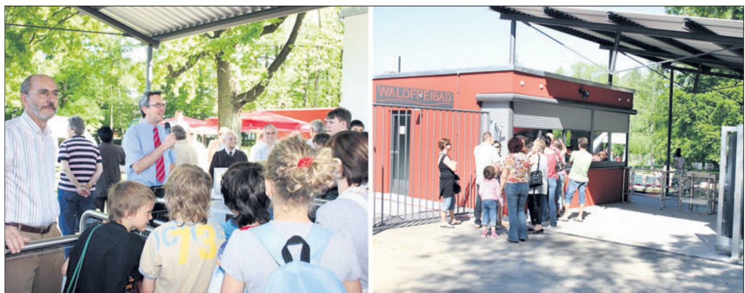
„Gut bedacht“ sind die Badegäste am Bittenfelder Waldfreibad von nun an, denn das Gebäude-Ensemble, der Kassen- und Umkleidebereich sowie der Kiosk sind komplett neu gebaut worden. Am Samstag, 10. Mai
