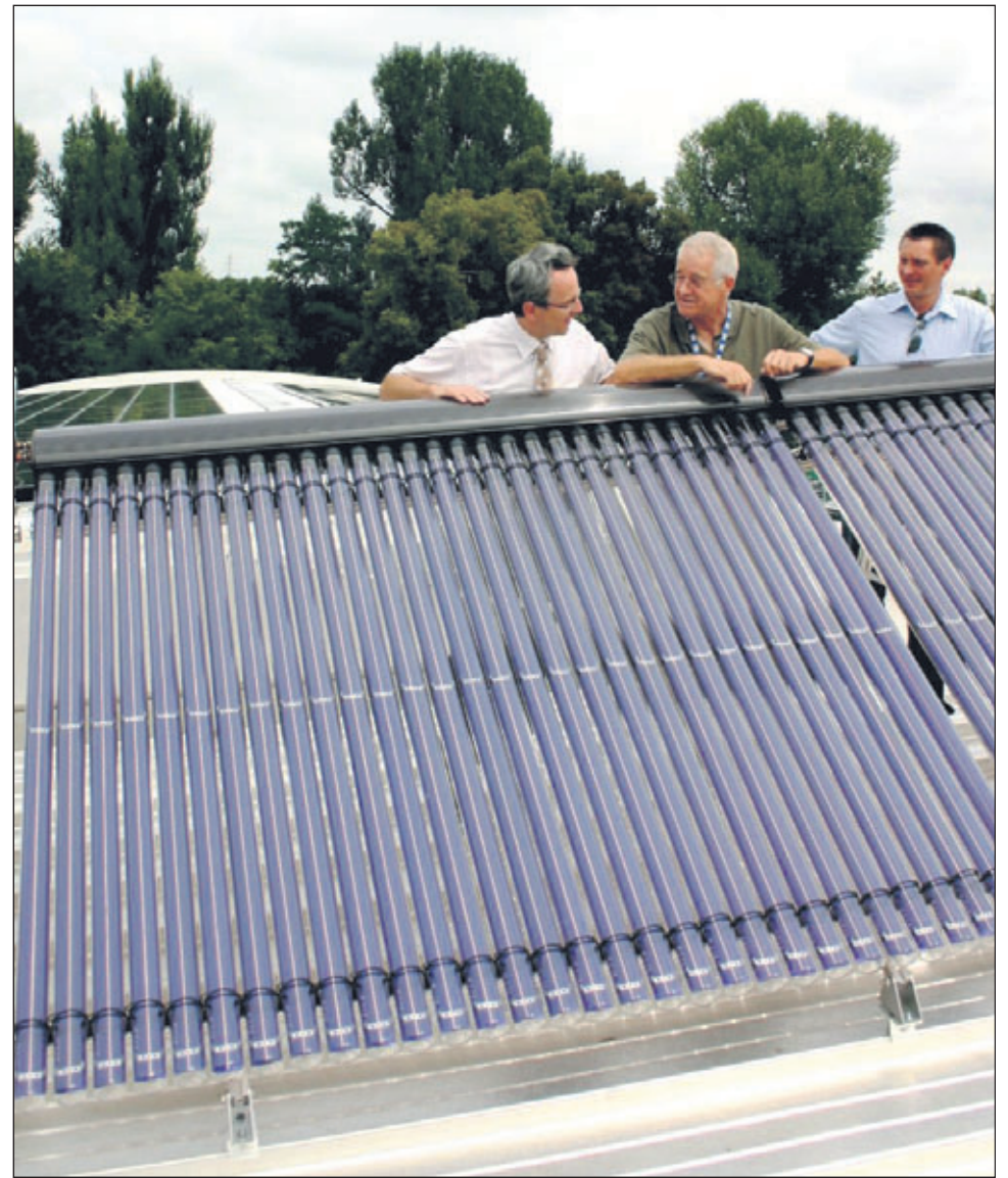
Oberbürgermeister Andreas Hesky, Klaus Sandkuhl aus dem VfL-Vorstand und Architekt Felix Kaden auf dem Dach des Vereinsgebäudes – im Vordergrund die Solaranlage, im Hintergrund erstreckt sich die Fotovoltaik-Fläche, die für „Sonnenstrom“ sorgt. Fotos: David
