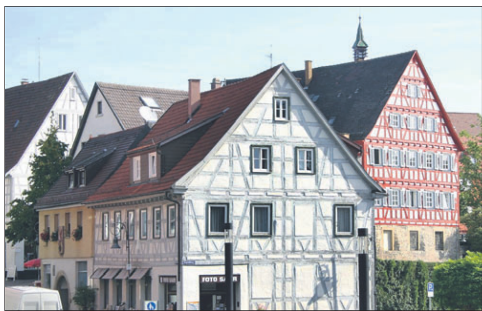
Die Fachwerk-Freilegung ist in diesem Jahr der Schwerpunkt des „Tags des offenen Denkmals“ am Sonntag, 14. September 2008. Der Heimatverein bietet Führungen an: Um 11 Uhr, um 14 Uhr und um 15 Uhr. Treffpunkt ist der Rathauseingang. Unser Bild zeigt das Gebäude Foto Saur und das erst jüngst restaurierte Haus „Schabel“, das wieder in kräftigem Rot erstrahlt. Foto: Redmann
