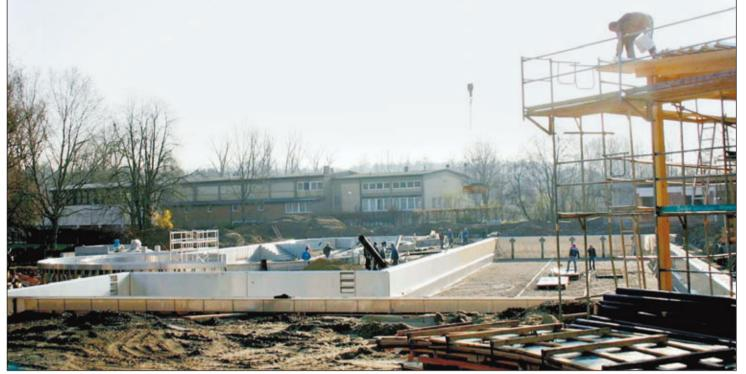
Noch ragt das neue Edelstahl-Becken im Waiblinger Freibad aus der Erde, doch deutlich erkennbar sind schon der Durchströmungskanal (links im Hintergrund) mit dem Erlebnisbereich, das tiefe Sprungbecken (vorne links) und rechts der Schwimmerbereich mit fünf Bahnen.
