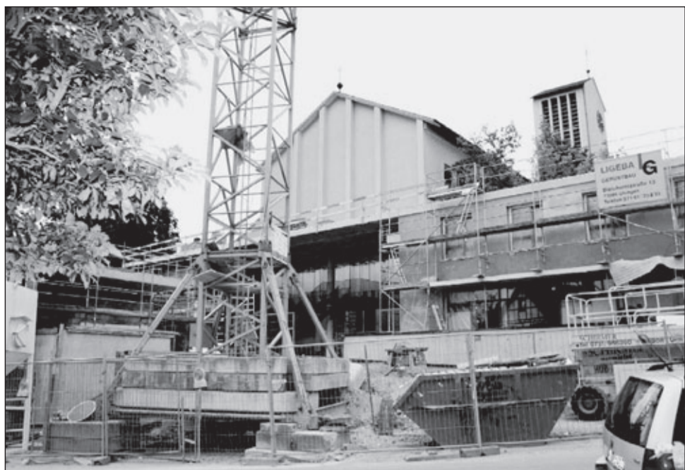
Großbaustelle „St. Antonius“: vor der Kirche entsteht derzeit das neue Gemeindezentrum. An den Kosten in Höhe von 1,16 Millionen Euro für den Kindergarten beteiligt sich die Stadt Waiblingen mit 50 Prozent.
