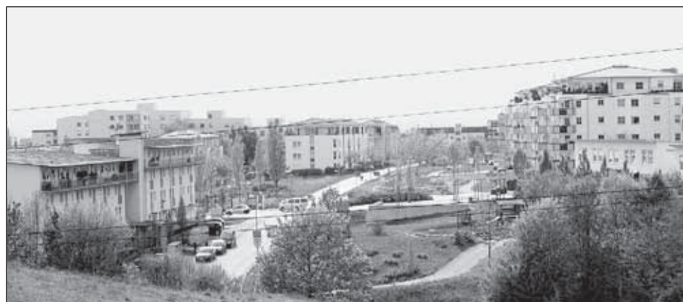
Die Korber Höhe ist gewachsen – längst ist zum ersten Bauabschnitt der zweite hinzugekommen (unser Bild zeigt einen Ausschnitt im April des Jahres 2004); und mittlerweile besteht die Bürgeraktion Korber Höhe seit drei Jahrzehnten. Foto: Archiv Pressereferat
