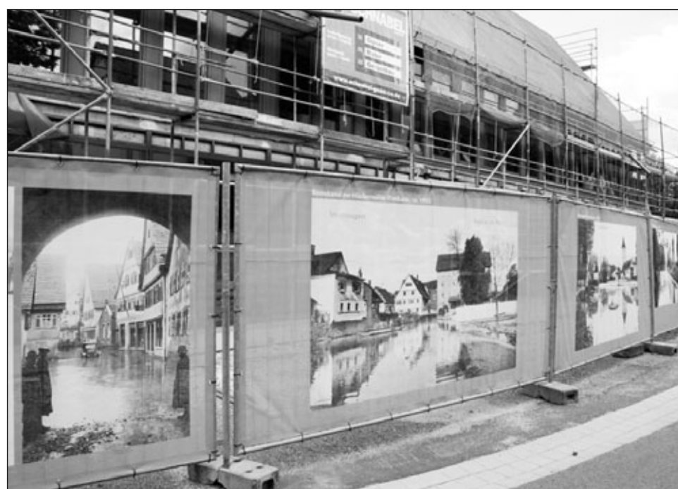
Historische Mühlenbilder und das Thema „Rems“ sind auf dem Bauzaun rings um die Baustelle „Häckermühle“ abgebildet – und allemal einen Rundgang wert. Foto: David
